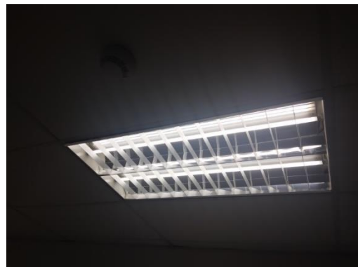
รูปที่ 22 ดวงไฟชนิดที่มีแผ่นช่วยสะท้อนและกระจายแสงแบบอลูมิเนียม
