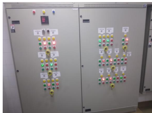
แผงควบคุมและมิเตอร์ไฟฟ้าของระบบบำบัด
