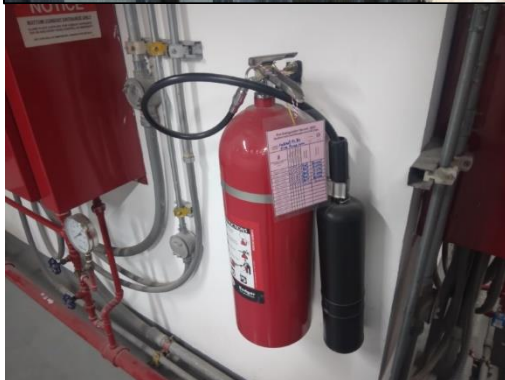
รูปที่ 32 เครื่องดับเพลิงแบบมือถือชนิดใช้ผงสารเคมีแห้ง
