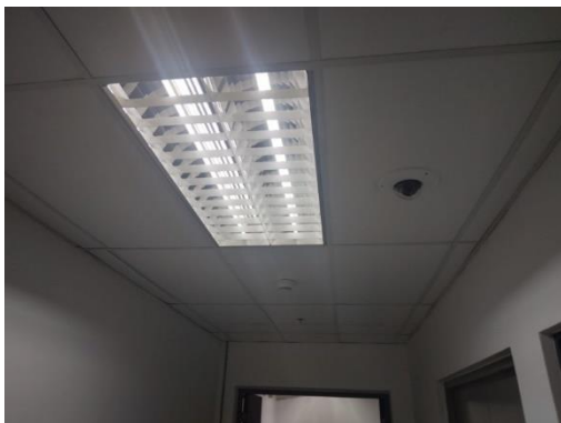
รูปที่ 22 ดวงไฟชนิดที่มีแผ่นช่วยสะท้อนและกระจายแสงแบบอลูมิเนียม
