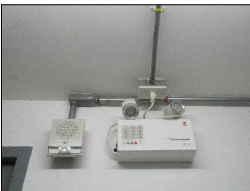
รูปที่ 38 ไฟส่องสว่างฉุกเฉิน
